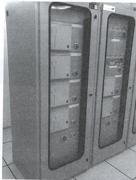
Рис. 2.64. Применяемый сегодня способ монтажа МУРЗ в шкафы
